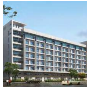
Niższe budynki wielkopowierzchniowe
