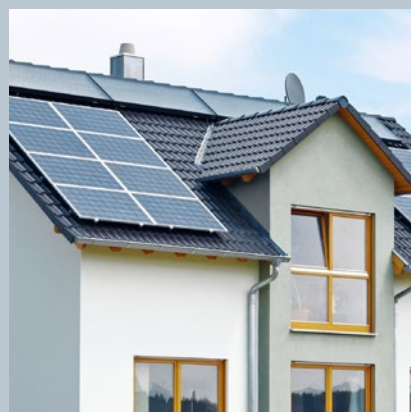
MODUŁY I INWERTERY FOTOWOLTAICZNE
