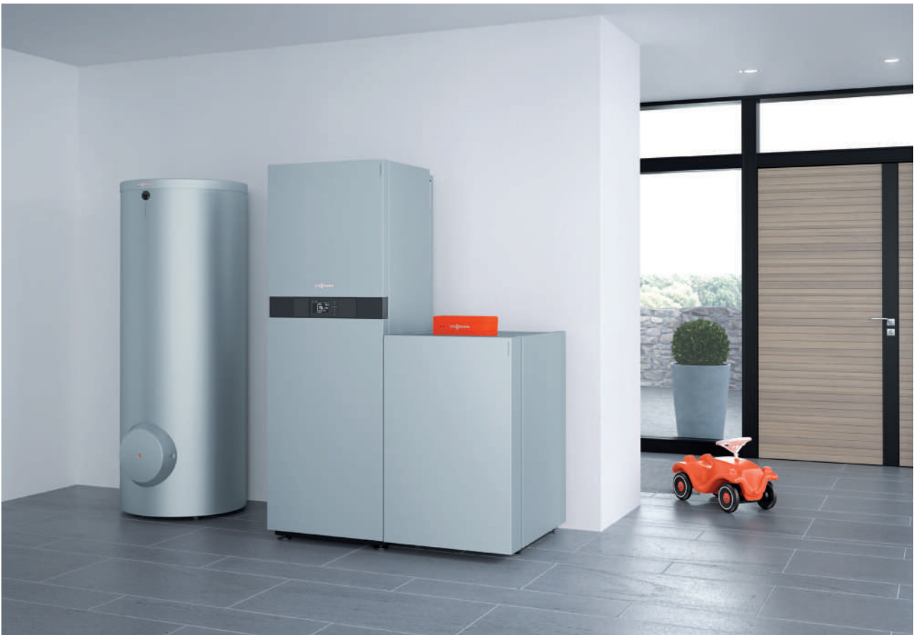
Pojemnościowy podgrzewacz c.w.u. Vitocell 100-V (typ CVAA), system akumulacji prądu Vitocharge oraz pompa ciepła Vitocal 300-G (od lewej)
